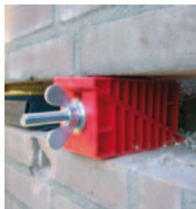
Het unieke instelbare opvulblok: onmisbaar hulpmiddel bij het tijdelijk ondersteunen van het buitenblad
