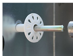
Sla de plug volledig in met behulp van slagpijpje.
