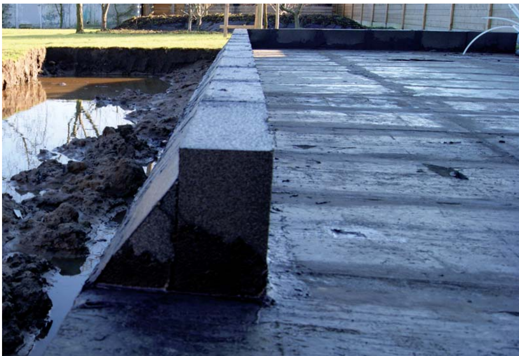
FOAMGLAS®-isolatie. Voor een passiefhuisstandaard wordt een isolatiedikte van 20 – 30 cm aanbevolen.
