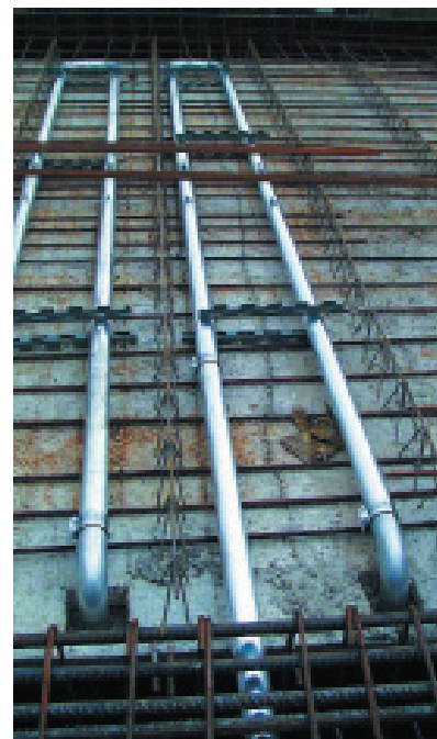
De koelbuizen worden in overeenstemming met het bouwraaster gemonteerd.
