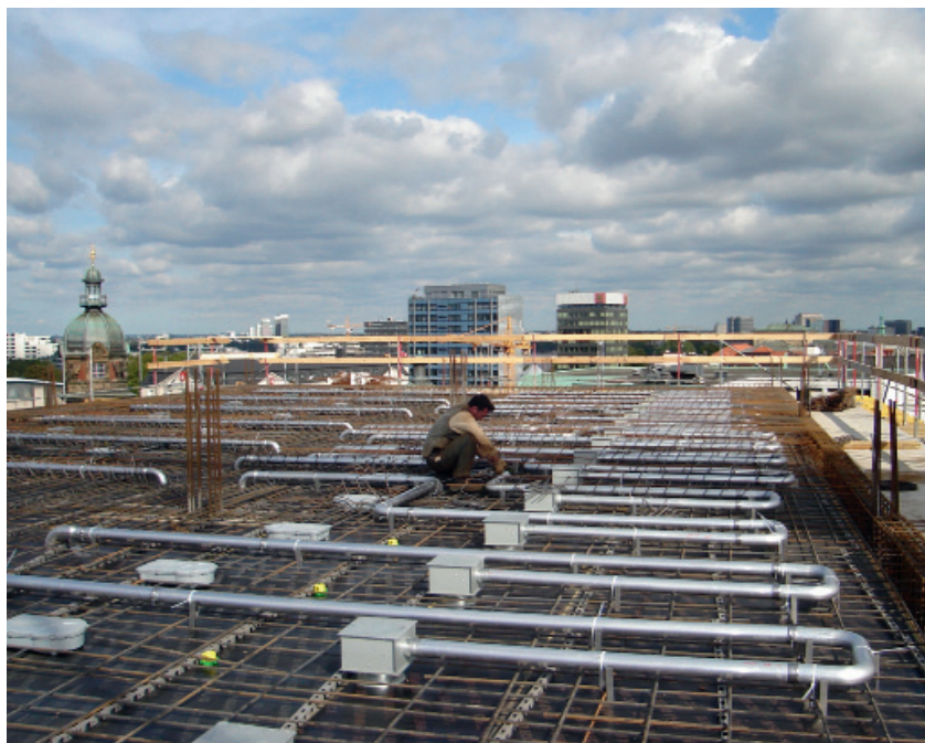
Koelbuizen worden in de statisch neutrale zone van de betonvloer aangebracht
