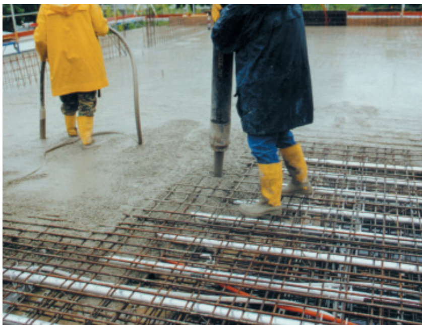
Op het werk gestorte vloer met CONCRETCOOL.
