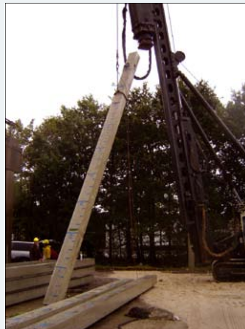
↑ Foto 3 Hijsen met een enkele strop
