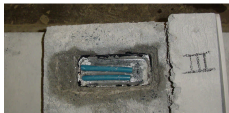
Koppeling aan de bovenzijde in een sleuf van de Klimaatsvloer
