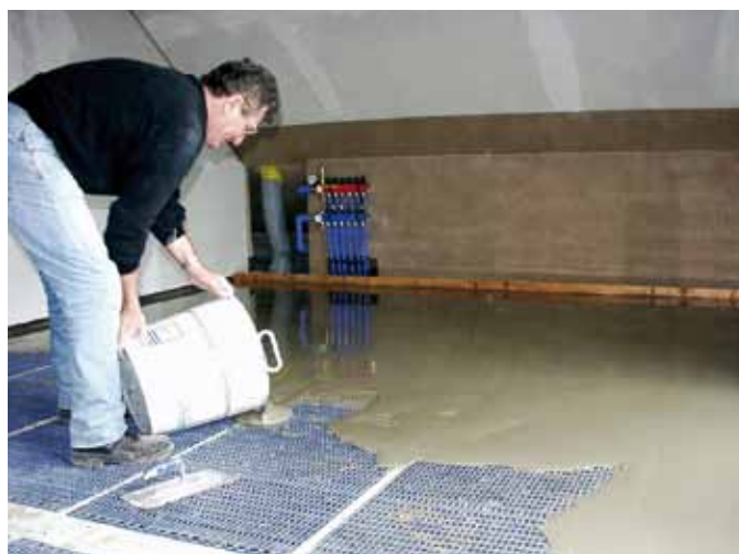
“FOLIMAT” verwarmings-/koelmatten direct onder de vloerbedekking.
