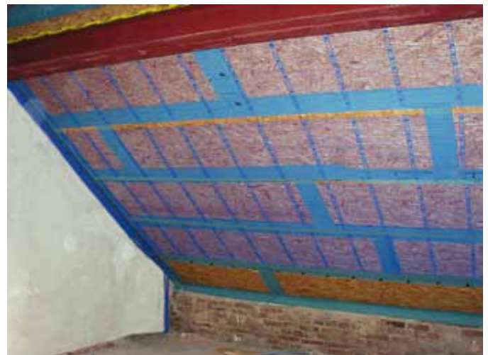
“OPTIMAT” verwarmings-/koelmatten in muren en plafonds.
