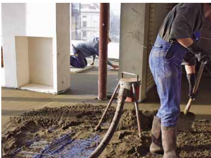
“OPTIMAT” verwarmings-/koelmatten in een dekvloer.
