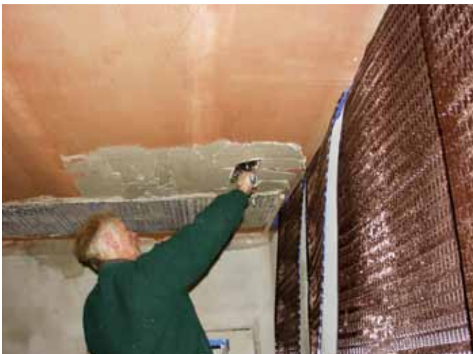
“FOLIMAT” verwarmings-/koelmatten in muren en plafonds.
